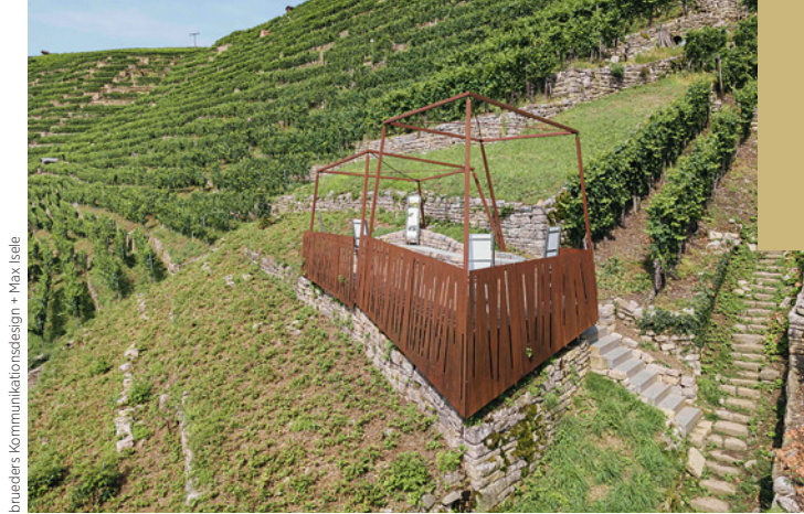
Ausgezeichnet mit dem Qualitätssiegel „Weinsüden Architektur“ und schon in der App: Weininformationspavillon, Besigheim | engelhard.eggler.architektur, Besigheim
